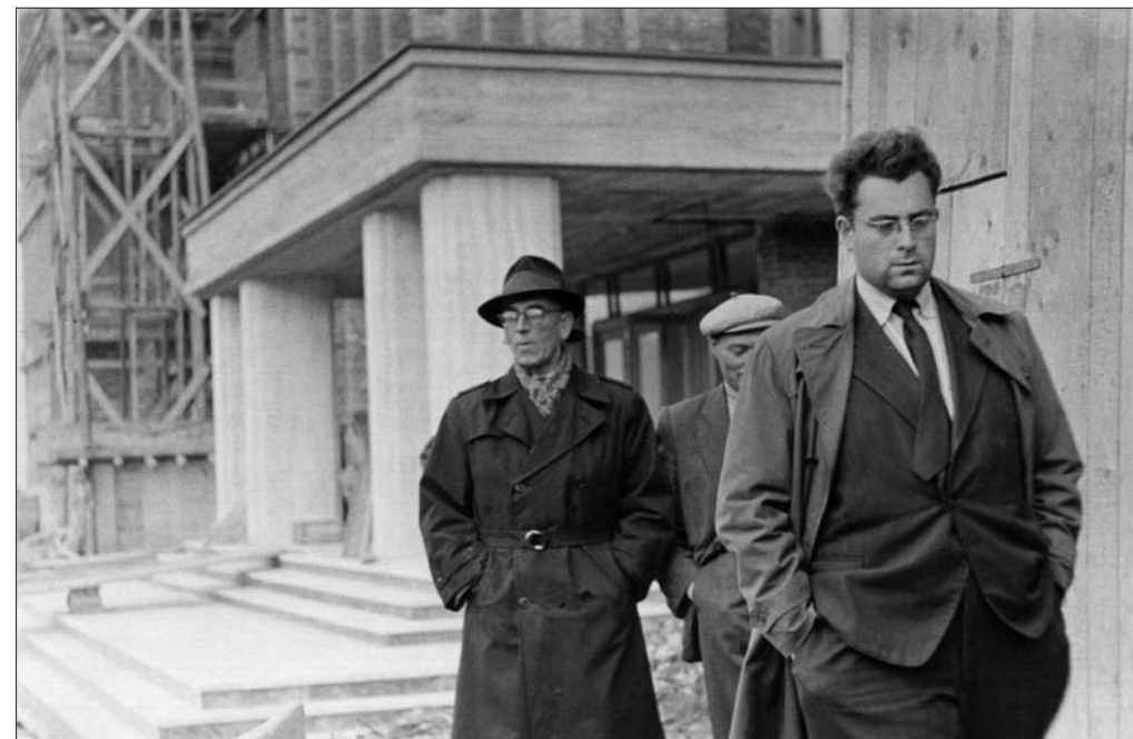
Kontrolný deň na novostavbe priemyslovky (zľava Ing. E. Philadelph, vedúci stavby p. Križka a Ing. M. Tuma)
