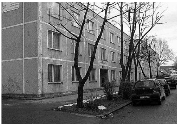
budova MMC SAV, zasadačka na prízemí vľavo
